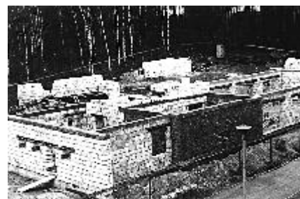
A tohle je pohled na rozestavěnou budovu DDM v roce 1977
